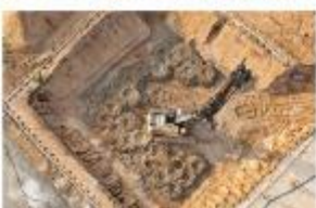
Tiefe Bodenvermörtelung (mas) Palau, Siedel
