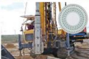
Rütteldruckverdichtung Deutschland, Zandorf
