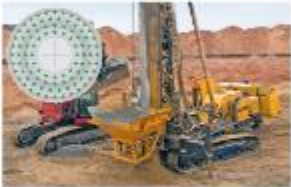
Betonrüttelsäulen Österreich, Halbmünz
