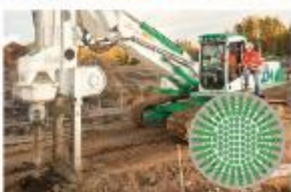
Tiefe Bodenvermörtelung (trucken) Schweiz, Schindler
