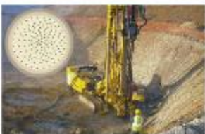
Verdichtungsinjektion Frankreich, Lezay
