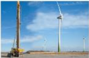
Rüttelstopfverdichtung Deutschland, Greifswald
